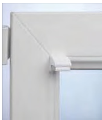
Spára zasklívací lišty
